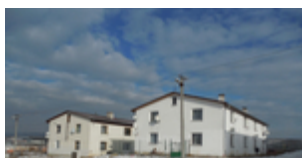
Bytový dom Lesná . 22, 23, 24, 25 a Bytový dom Potočná ul.
